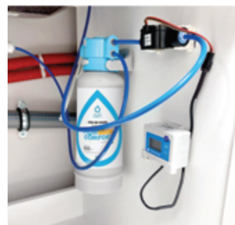
Esempio di posizione di montaggio
