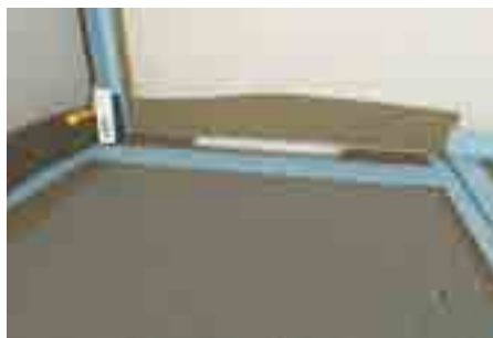
8. Aplikovat těsnicí pásy po obvodu modulu žlabu a prostoru sprchy, utěsnit hydroizolační stěrkou celou plochu sprchy
