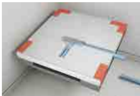
2. Sprchovou desku otočit, vybrat směr odtoku, vyjmout ochranné kryty a napojit odpadní potrubí
