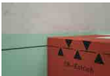
4. Pro skladbu podlahy - betonové mazaniny je nutné dbát na to aby rysky na sprchové desce „OK-Estrich“ odpovídaly horní ploše betonového potěru podlahy
