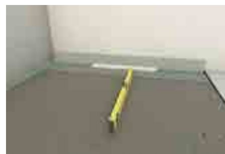
6. Spádovat betonovou mazaninu min. 2% k přední hraně žlabu
