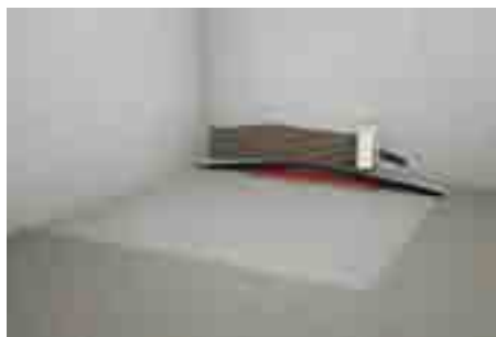
7. Nanést vodotěsné izolace a všechny stavební přechody řešit pomocí dilatační těsnicí pásky
