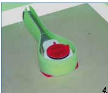
**DE Einbauhöhe min. 12,5 cm (bei Duschelementgröße ab 130 cm: min. 13,5 cm), Position des Ablaufs markieren**
