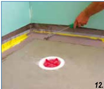
DE Abdichtband mit Dichtmasse anbringen
