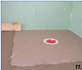
DE Bei Einbau von Unterbauelementen HL523U: Estrich abziehen, aushärten lassen
