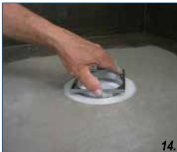
DE Aufsatzrahmen einsetzen, Höhe einstellen, Baustützrahmen einsetzen
